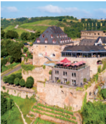
Eine der Hauptattraktionen in St. Goar ist die Burg Rheinfels aus dem Jahr 1245.
